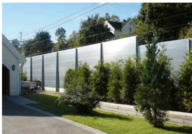
Ljuddämning och insynskydd vid järnväg Oslo, Norge.
