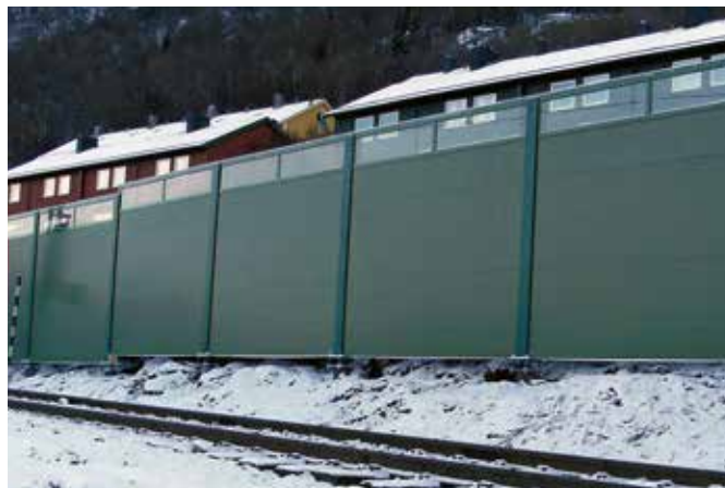
Ljudabsorberande bullerskärm med glasning Narvik, Norge (Obs: 4 m mellan stolparna).
