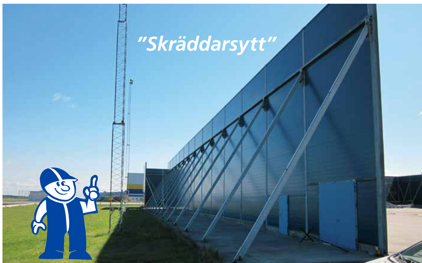
Ljuddämpning testanläggning jetmotorer Arlanda flygplats.
