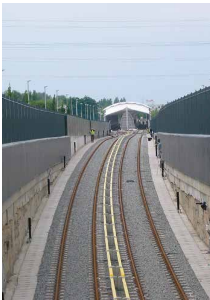
Bullerskärm vid nedfart tunnelbana Bryssel, Belgien.
