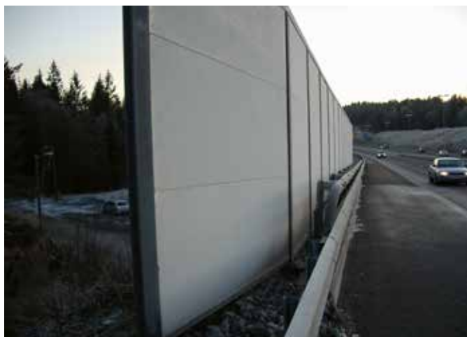
Bullerskärm i aluminium, beständig mot salt, vid väg E6 Mossporten, Norge.
