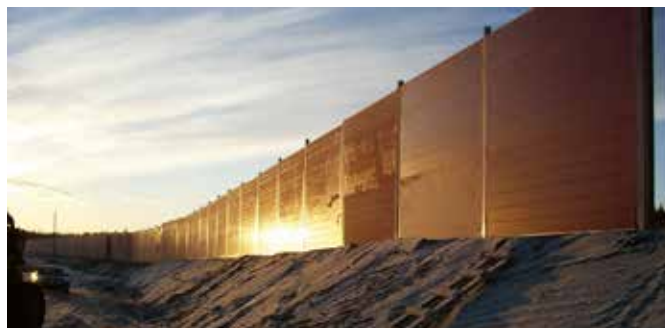
Bullerskärm vid väg E10 mot lossningsstation för järnmalm Svappavaara, Sverige.
