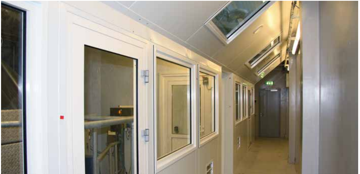
Inkapsling/skiljeväggar produktionsanläggning Novozymes A/S, Bagsvaerd Danmark.
